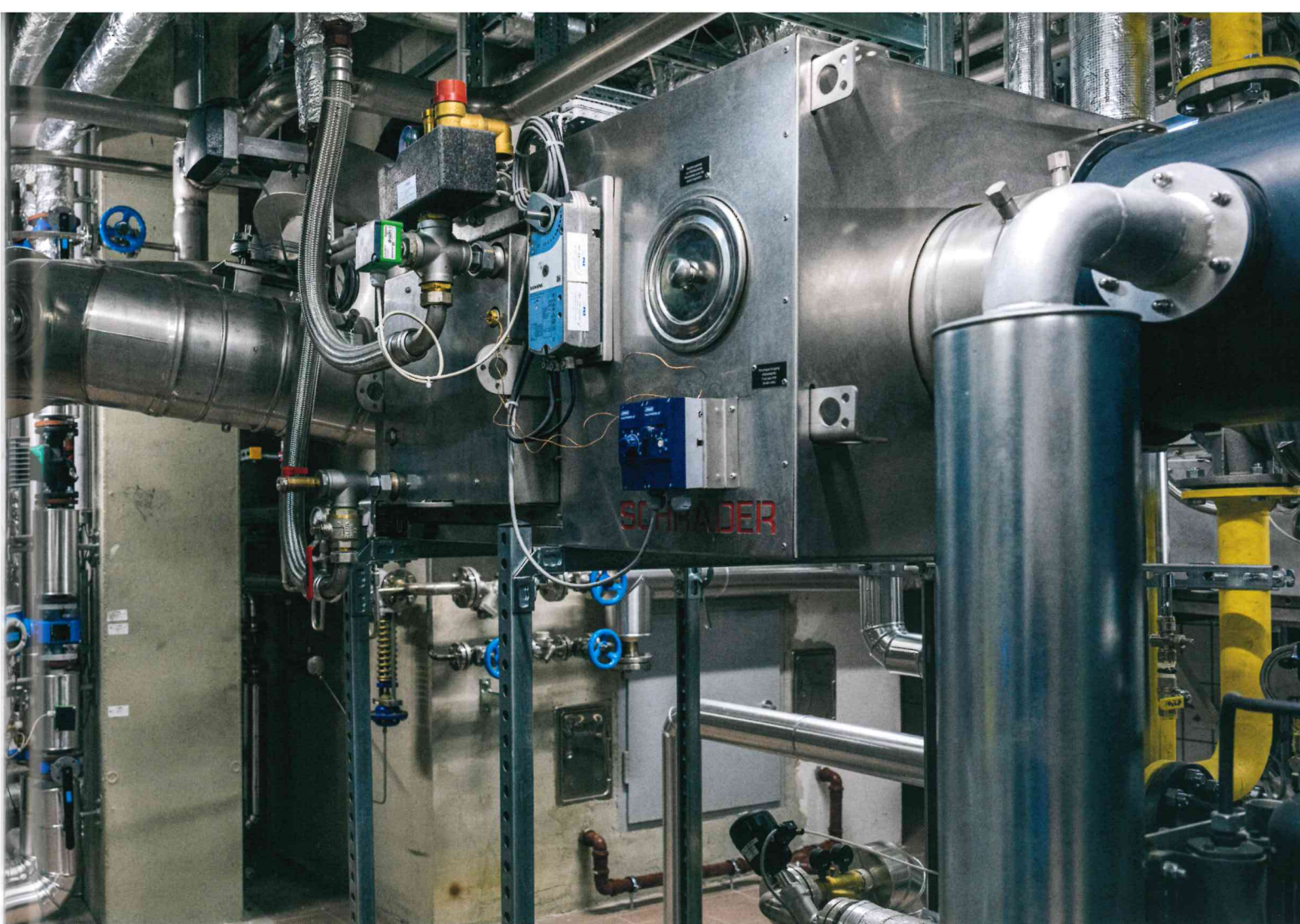
Herzstück des neuen Wärmekonzepts: Der Schröder Abgaswärmetauscher mit integriertem Bypass für den Dampfkessel CERTUSS 850.
