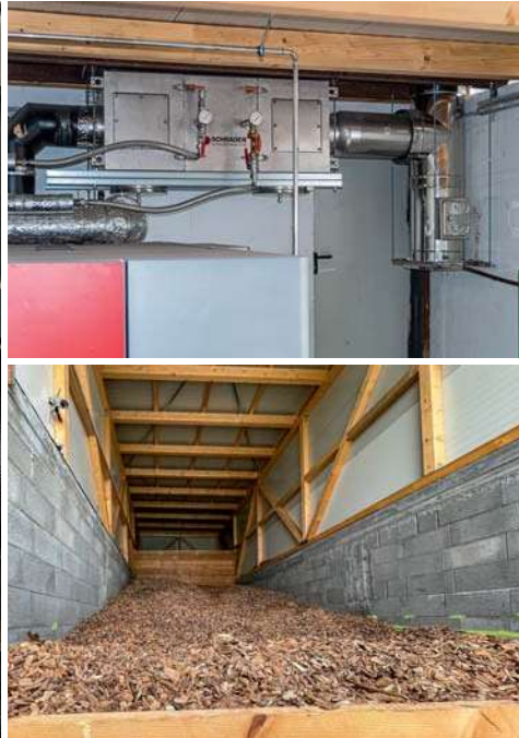
Alles wird überwacht: Die Aschebox, der Abgaswärmetauscher und das Hackgutlager.
